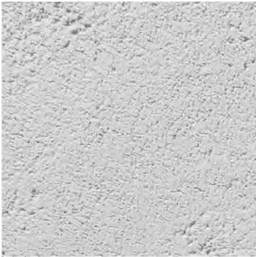
スアナ 塗り付けた後、スアナのような模様をつけランダムに表面を押さえた仕上げ。 仕上厚：3mm
